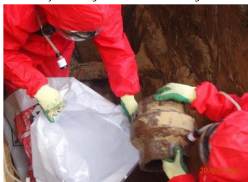
Foto 6: mofverbinding tussen twee buizen uitgesneden
