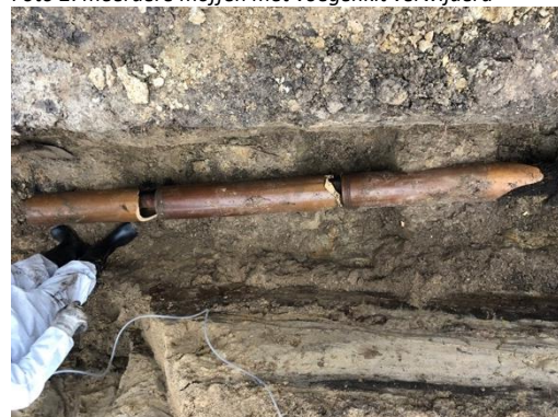
Foto 2: meerdere moffen met voegenkit verwijderd
