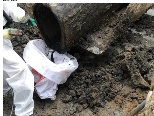
Foto 35: Aanvullend saneren van de voegenkit met hamer en beitel
