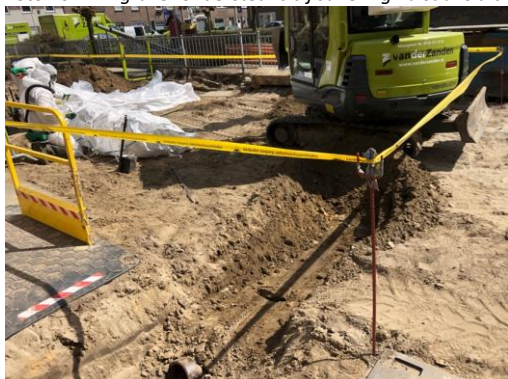
Foto 26: Minigraver ondersteunt bij sanering huisaansluiting
