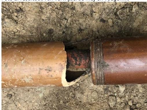
Foto 1: resultaat van verwijderde mof en voegenkit
