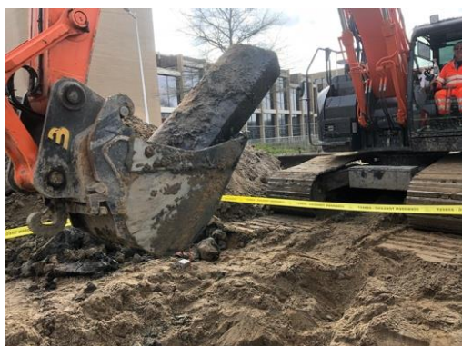
Foto 7: Wegnemen van eibuizen met een grondbak
