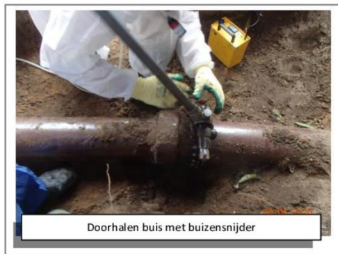
Foto 28: Doorhalen met de buizensnijder
