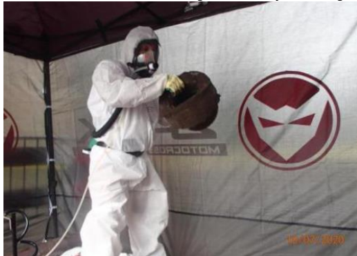
Foto 30: Laten vallen van een uitgesneden mofverbinding
