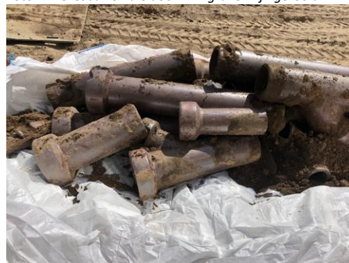
Foto 27: Gresbuizen die door minigraver zijn gerooid
