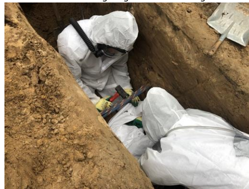
Foto 25: medewerkers gebogen over het werkgebied
