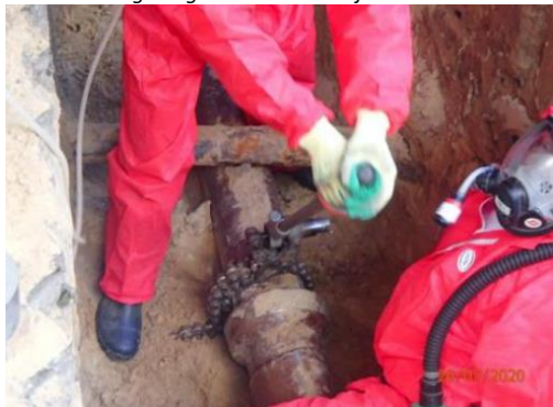
Foto 5: ketting aangebracht t.b.v. snijden van de buis
