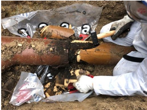
Foto 22: het breken van de mofverbinding met een vuistje
