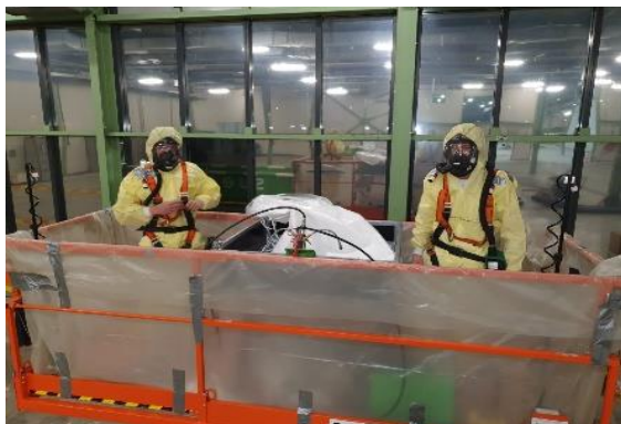
Foto 7: opstelling in een hoogwerker
